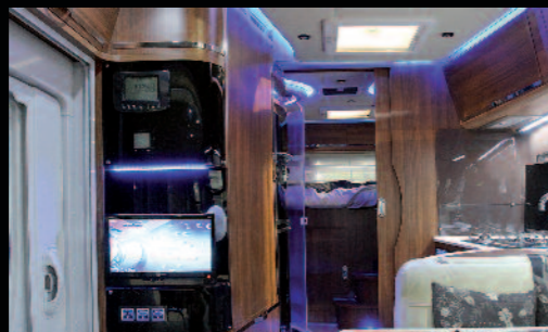
INSTALLAZIONE LUCI LED E MONITOR TV SU CAMPER
